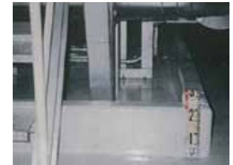
防油堤の設置
