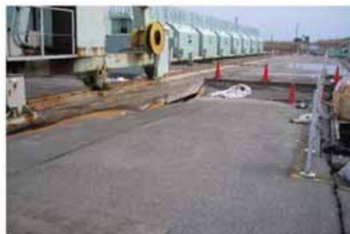
写真④(取水口エリア)
