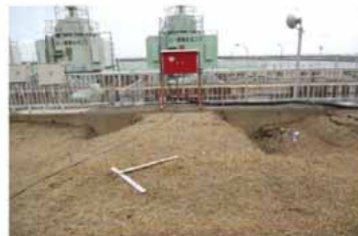
写真②(循環水配管埋設エリア)
