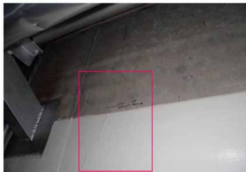
原子炉建屋5階壁面
