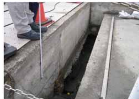
写真⑤(取水口エリア)
