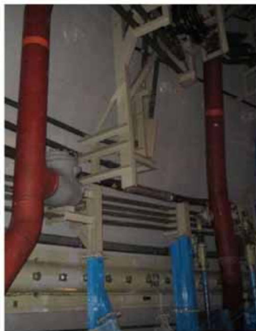
仮設足場組立前
