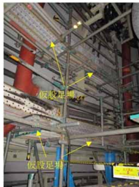
仮設足場組立後
