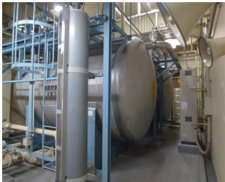
廃液貯槽室(タンク)
