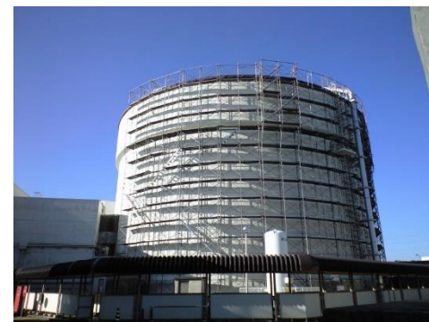
原子炉建家の足場
