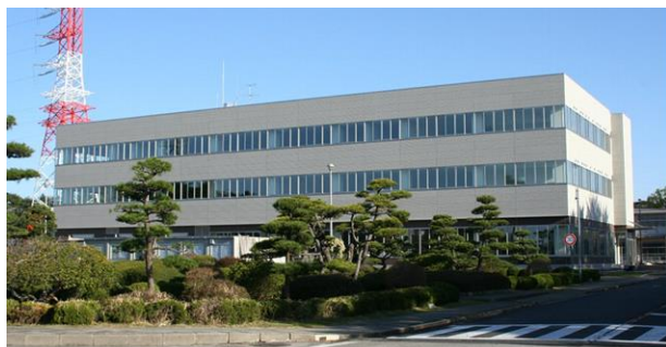
緊急時対策所
