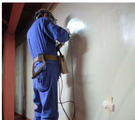
ひび割れ調査
