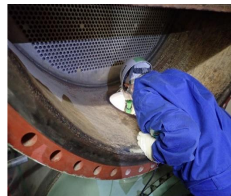
1次冷却材熱交換器の開放点検
