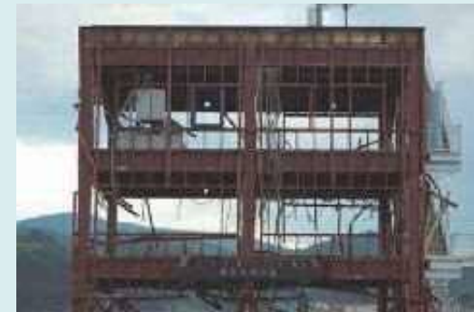
構造: 鉄骨造 規模: 3階建て 縦11.4m × 横8.8m × 高さ10.9m
