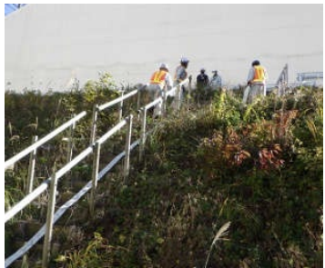
法面でのホース敷設
