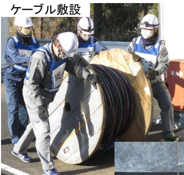
ケーブル敷設
