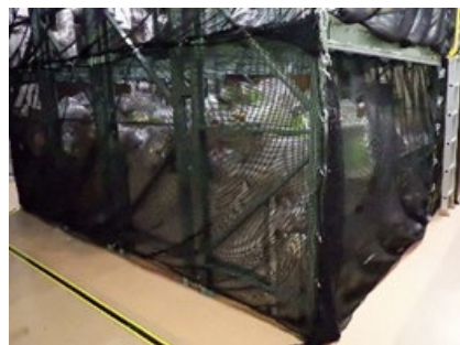
廃棄物保管棚へのネットの設置
