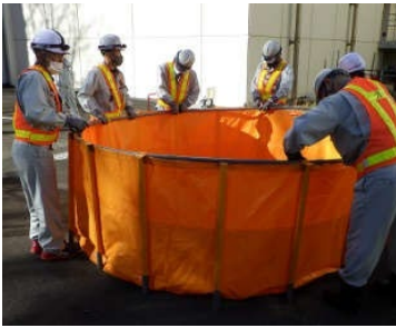
組立式水槽の設置
