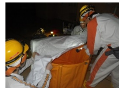
⑧給水作業
