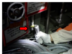
⑥仮設ホース接続
