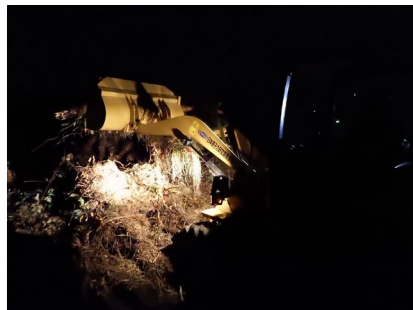
ホイールローダによるがれき撤去(夜間)
