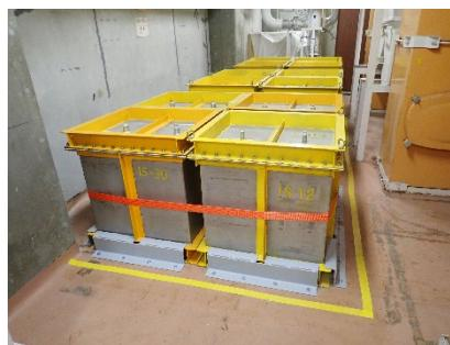
ヨウ素フィルタ保管容器の連続・床面への固定
