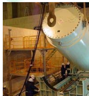
④ 建屋内でのキャスクの立起し作業 使用済燃料-33
