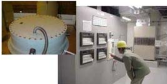
二重蓋間圧力監視(密封性確認)
