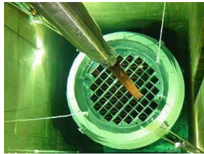
① 燃料プール内での使用済燃料装荷作業
