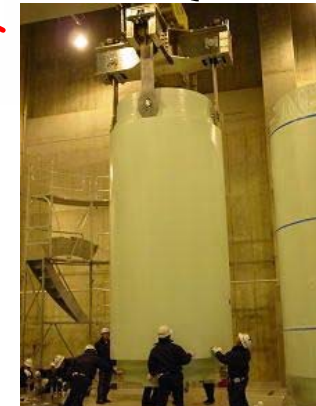
⑤ 乾式キャスクの移動作業
