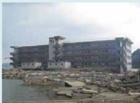
構造:鉄筋コンクリート造 津波浸水深:15.4m
