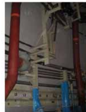
仮設足場組立前
