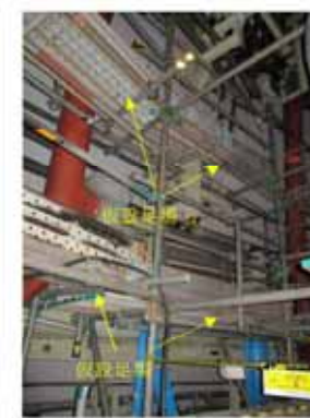
仮設足場組立後
