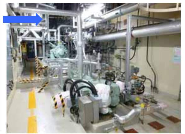
<参考> 原子炉隔離時冷却系ポンプ・タービン 設置場所(既設設備の配置例)
