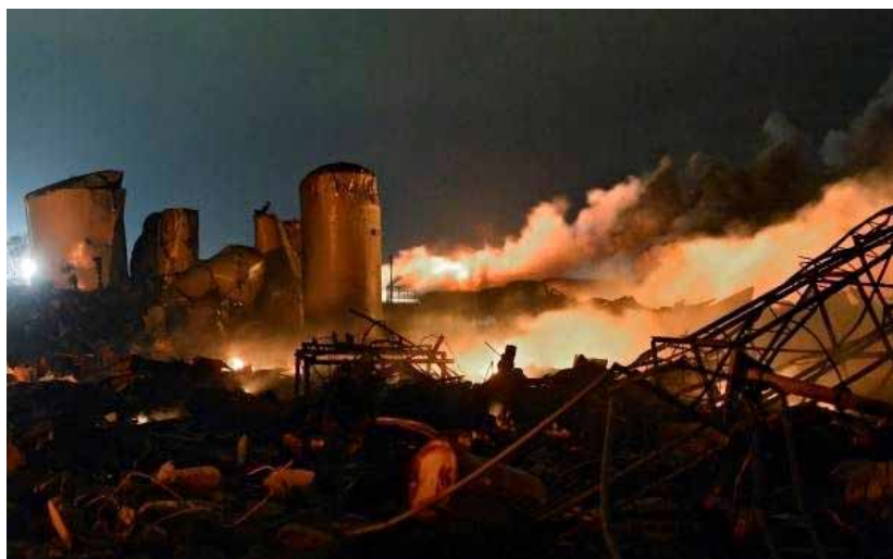
化学肥料工場の事故時の状況
