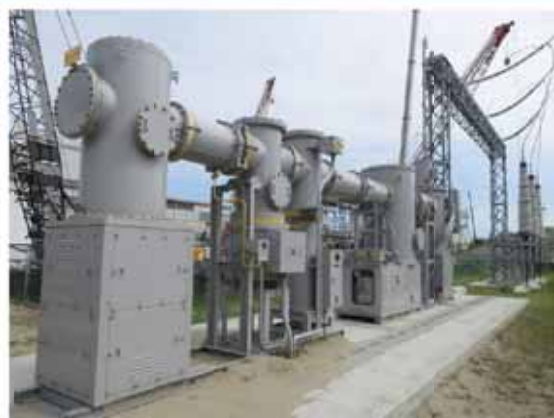
ガス絶縁開閉装置への設備変更
