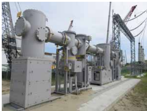
ガス絶縁開閉装置への設備変更
