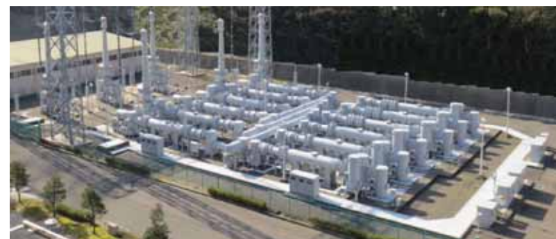
ガス絶縁開閉装置(イメージ)
