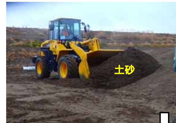
重機により土砂を撤去
