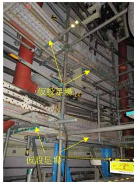
仮設足場組立後
