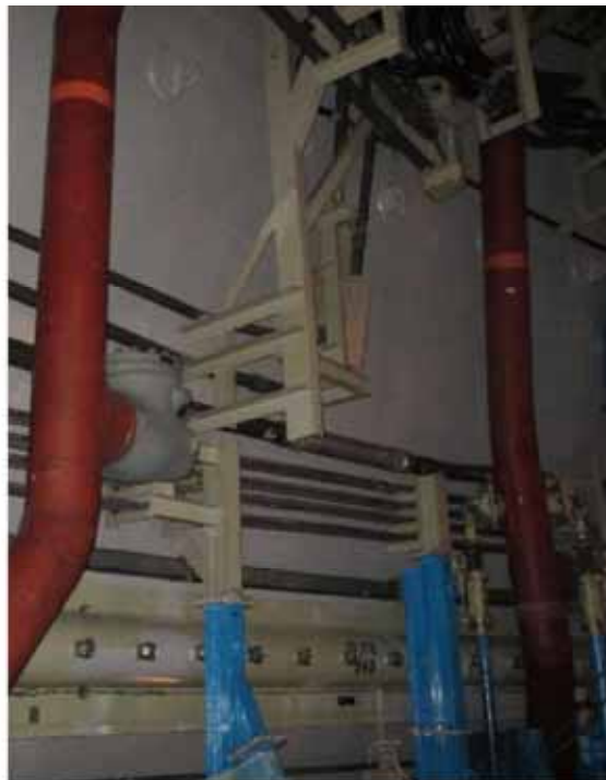
仮設足場組立前
