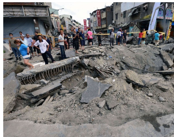
ガス爆発現場の状況
