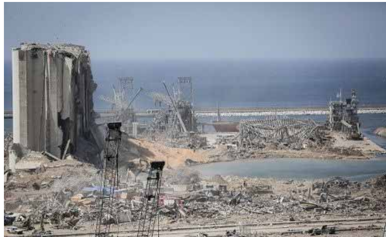
破壊された穀物倉庫(左)と爆発現場のクレーター(右)
