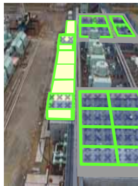
海水ポンプ室
