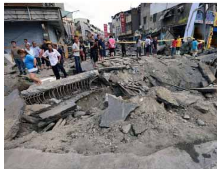
ガス爆発現場の状況
