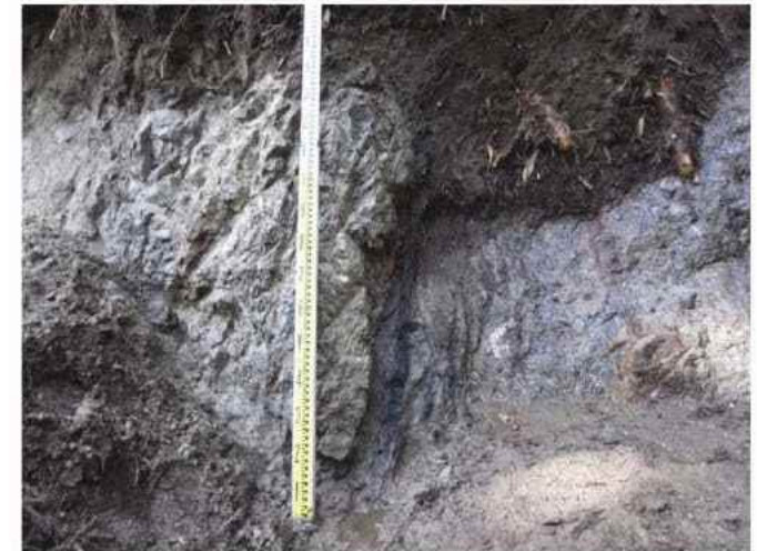
写真① 断層部の全景
