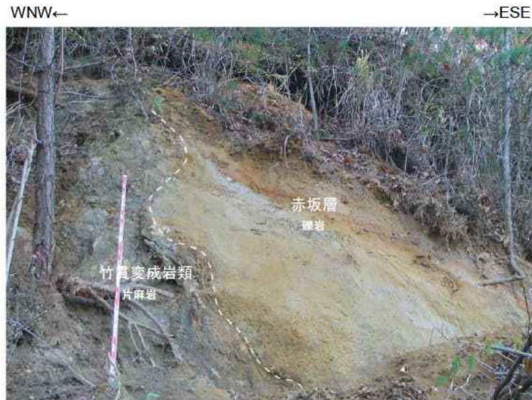
不整合露頭② 全景写真
