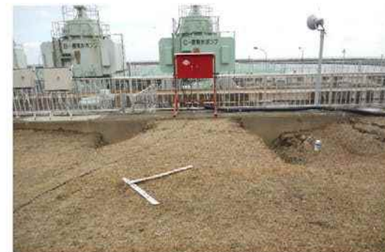
写真②: 地盤の沈下状況(循環水配管埋設エリア)
