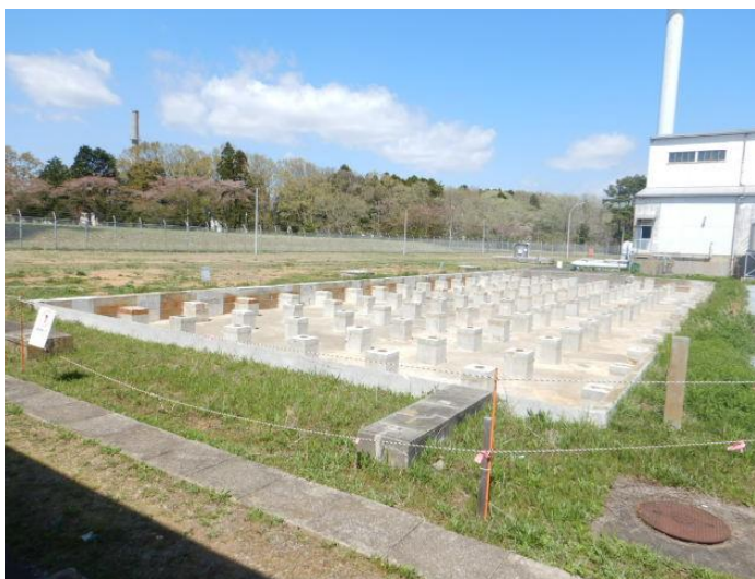
冷却塔基礎部
