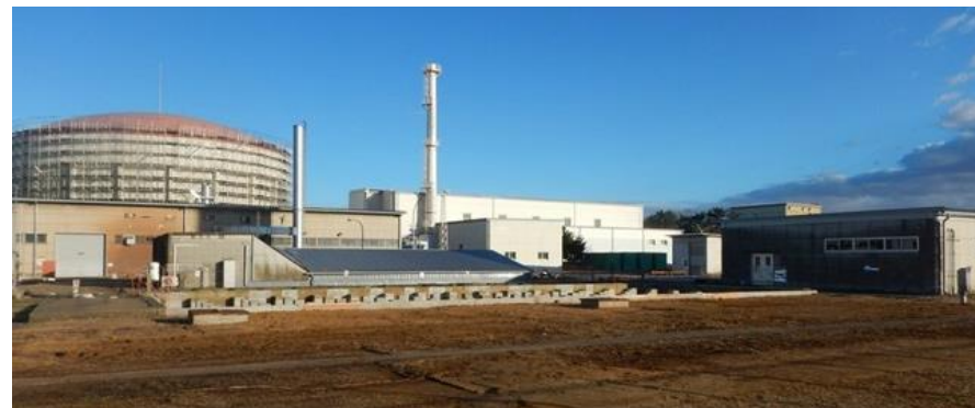
撤去後状況 (西側) (令和2年1月31日撮影)
