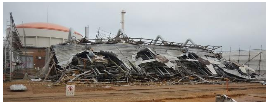
撤去中状況 (西側) (令和元年12月11日撮影)
