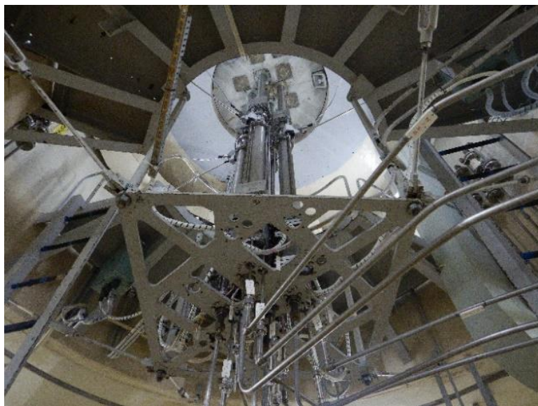
制御棒駆動装置写真(下方より撮影)
