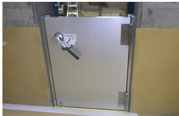
止水板の設置例
