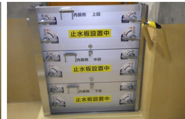
止水板の設置例
