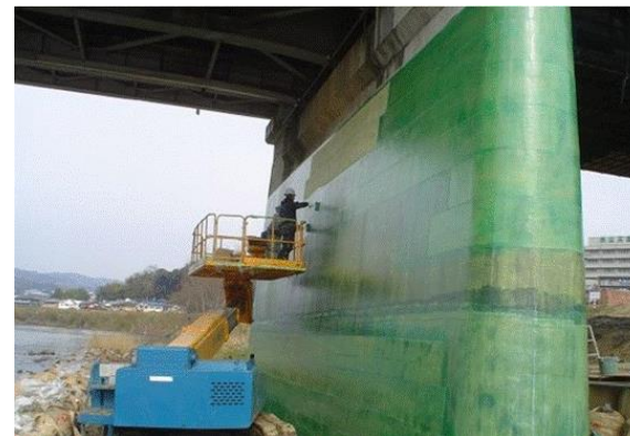
アラミド繊維シートによる橋脚補強 (一般施設に対する施工例)
