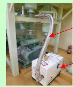
可搬式ブロワのフレキシブル配管を既設配管へ接続した状態
