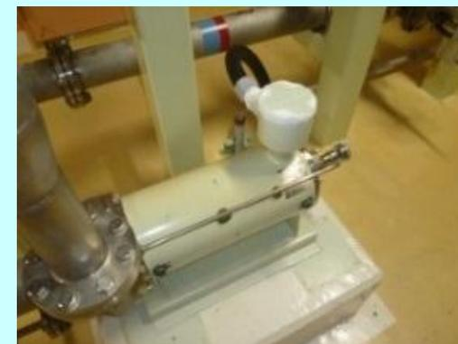
低層階の冷却水ポンプの防水処置
