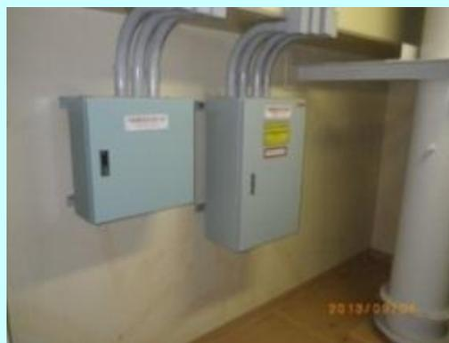
緊急電源切替盤を上層階へ移設
