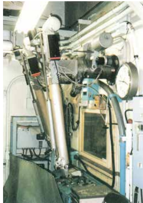
操作区域（G115）のセル監視窓、マニプレータ
