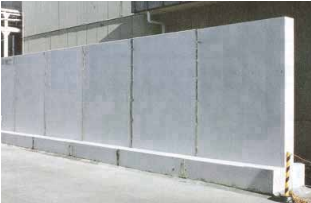
転換試験棟前に設置されたコンクリート壁
