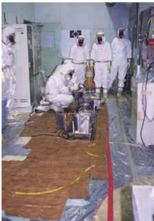
沈殿槽からの溶液抜き取り作業
