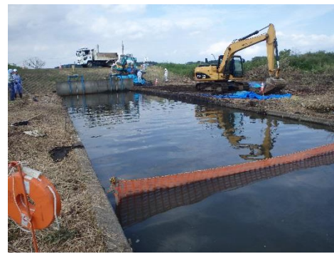
作業後の様子
