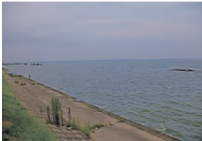
霞ヶ浦湖岸に築かれたコンクリート護岸堤
