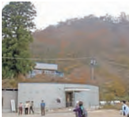
筑波山山頂付近に整備したトイレ
