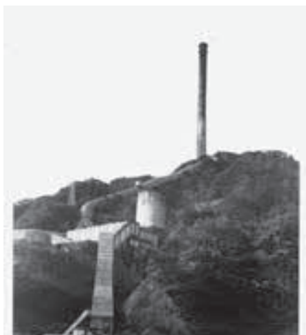
大正3年 日立鉱山の煙突完成
