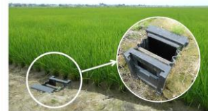
田んぼダム用落水口の一例
