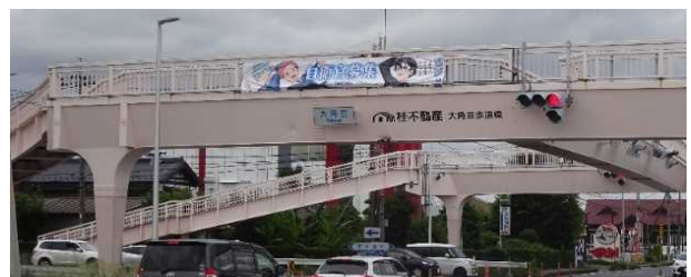
桂不動産 大角豆歩道橋 (大角豆歩道橋)
