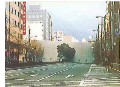
【緊急輸送道路の閉塞】
