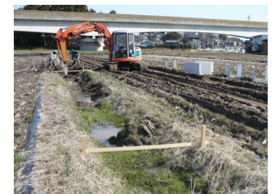
資源向上支払(コンクリート水路敷設)
