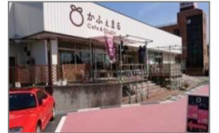
空き店舗のリノベーション
