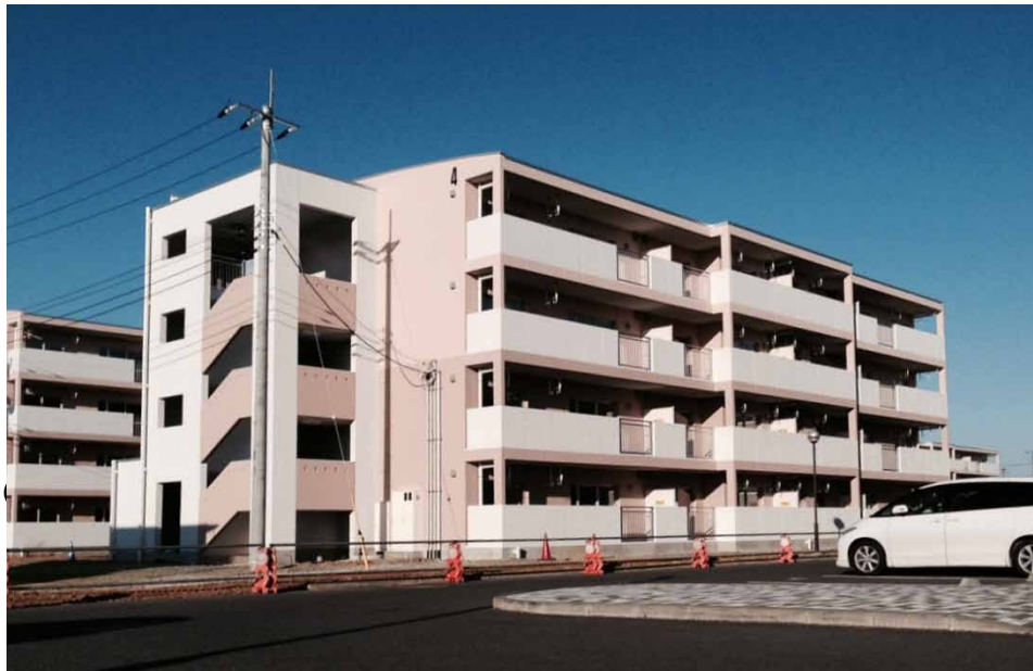
藤が原アパート4号棟(外構工事は平成26年3月15日完成予定)
