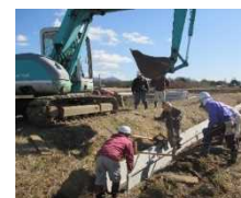
コンクリート水路の布設
