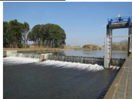
ため池等整備事業（河川応急） 茂田堰地区
