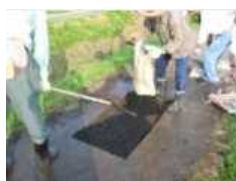
農道の部分補修
