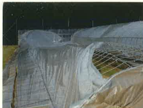
図3 風による倒壊、被覆ビニルの破損
